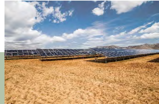
Lösungen für Offgrid & Backup
